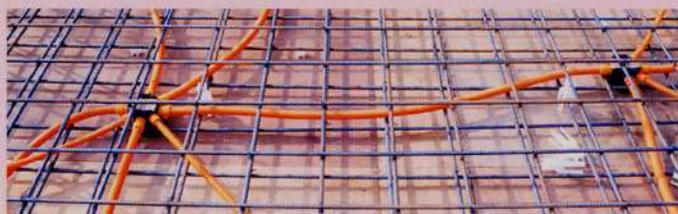
●施工時のCD管の先行埋設配管工事
